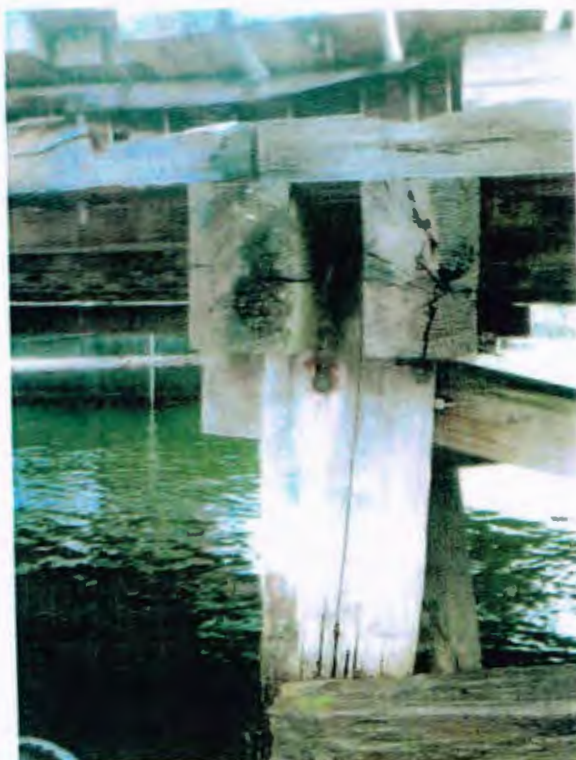
Bilder 30 und 31: Das Innere des Balkens ist zerstört. Dieses Schadensbild ist typisch für Kesseldruck- imprägnierte Hölzer
