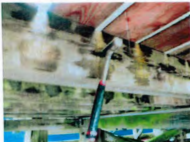
Bilder 26 und 27: Das Innere des Balkens ist zerstört. Dieses Schadensbild ist typisch für Kesseldruck- imprägnierte Hölzer
