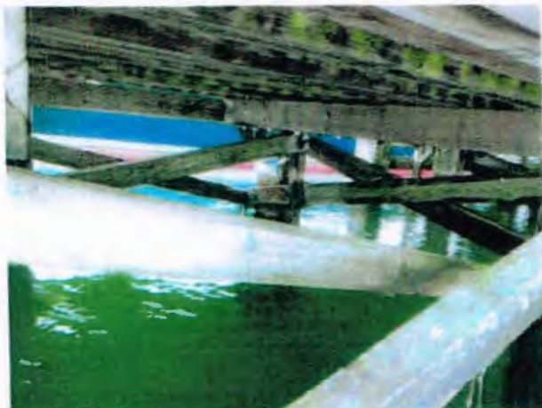
Bild 7: Turm-artige Konstruktion aus jeweils vier verstreuten Pfählen.
