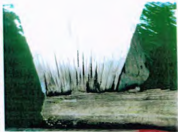
Bilder 12 und 13: Pfahl Süd 3 zeigt an der Kontaktfläche zur Strebe oberflächliche Schäden.
