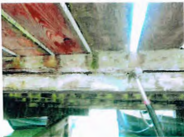
Bilder 28 und 29: Das Innere des Balkens ist zerstört. Dieses Schadensbild ist typisch für Kesseldruck- imprägnierte Hölzer
