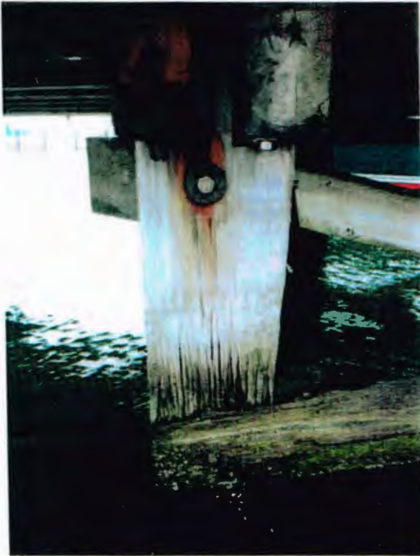
Bilder 12 und 13: Pfahl Süd 3 zeigt an der Kontaktfläche zur Strebe oberflächliche Schäden.
