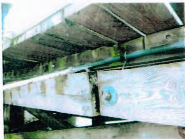
Bilder 30 und 31: Das Innere des Balkens ist zerstört. Dieses Schadensbild ist typisch für Kesseldruck- imprägnierte Hölzer
