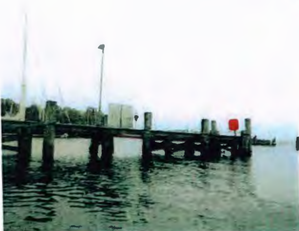
Bilder 35 und 36: Die Konstruktion entspricht der KFK-Brücke. Die Dalben haben keine tragende Funktion
