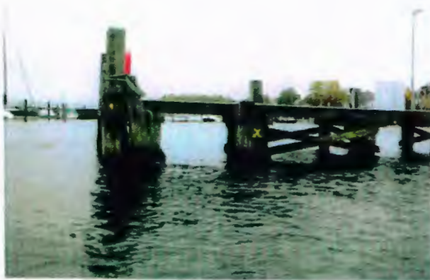
Bild 38: Dalben D1 und D2 Süd. Dalbe 2 ist stark geschädigt, siehe Grafik 13.
