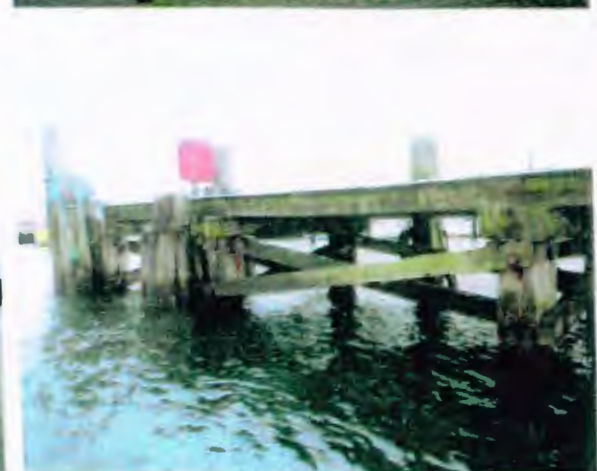
Bilder 35 und 36: Die Konstruktion entspricht der KFK-Brücke. Die Dalben haben keine tragende Funktion
