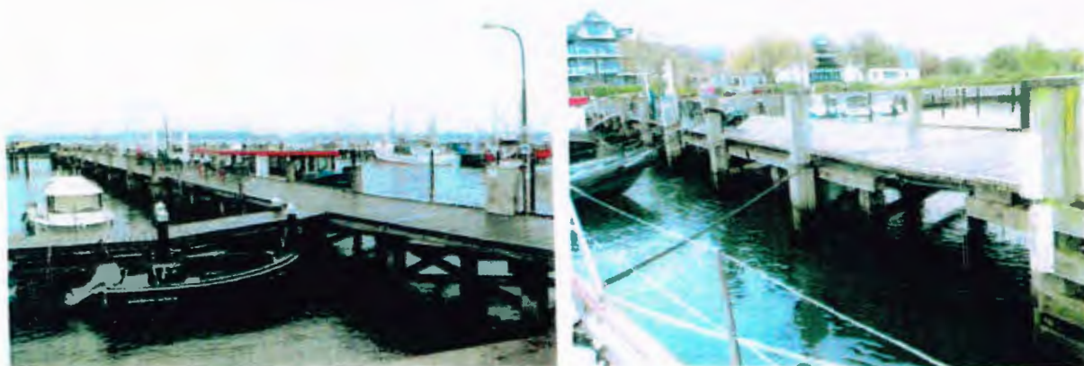
Bild 1 und 2: KFK Brücke. Die Dalben beginnen erst See-seitig des ersten Steges
