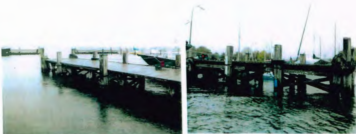
Bild 3 und 4: KFK-Brücke. 4er und 2er Verbünde wechseln sich im Tragwerk ab. Die Köpfe der Dalben sind mittels Metall-Kappen abgedeckt.
