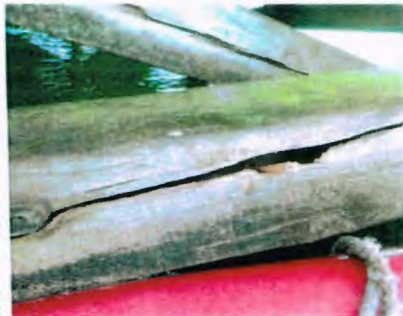
Bilder 26 und 27: Das Innere des Balkens ist zerstört. Dieses Schadensbild ist typisch für Kesseldruck- imprägnierte Hölzer
