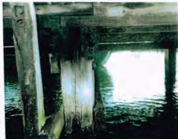
Bilder 28 und 29: Das Innere des Balkens ist zerstört. Dieses Schadensbild ist typisch für Kesseldruck- imprägnierte Hölzer
